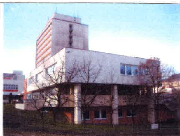
Obr. 08. Jihozápadní a jihovýchodní průčelí části „B“. Na snímku je patrné osazení stavby na svahu k ulici Hoření.
