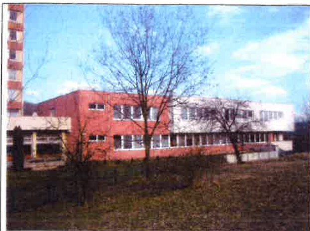
Obr. 07. Jihozápadní průčelí části „A“.
