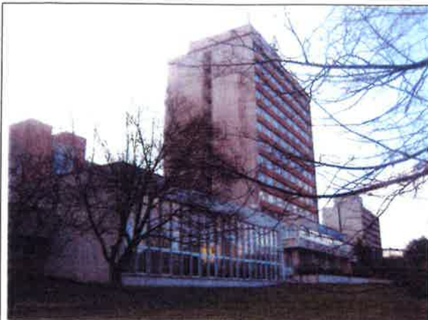
Obr. 01. Severovýchodní průčelí monobloku. V popředí je „velká“ tělocvična v podnoží části „C“. V pozadí za výškovou částí „A“ je zdevastovaný objekt bývalého hotelu „Máj“.
