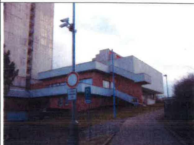
Obr. 04. Severovýchodní a severozápadní průčelí části „C“. Součástí části je reprezentační aula.
