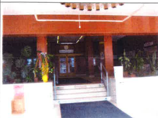
Obr. 09. Vestibul společného hlavního vstupu do monobloku univerzity je v 1.n.p. z jihozápadního průčelí podnože části „A“.
