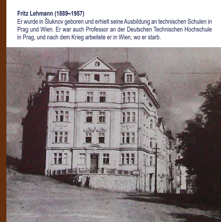
Block D des Gemeindebaus von 1922
