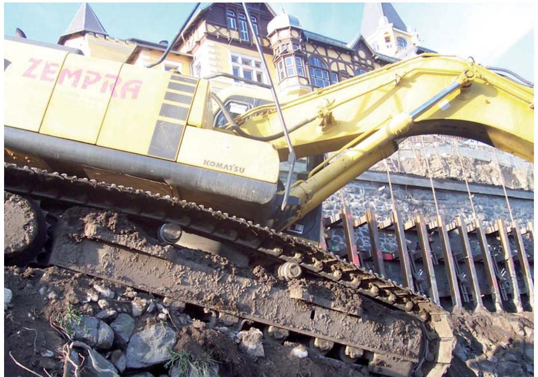
Práce na zabezpečení svahu pod Větruši se blíží ke konci.
