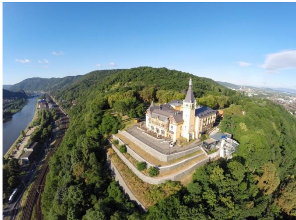
Obr. příloha A1: Výletní zámek Větruše
