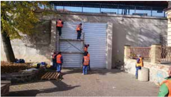
Instalace zábran v ulici K Můstku
