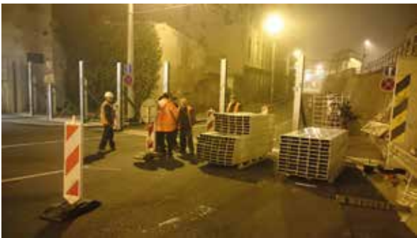
Instalace zábran v ulici Malá Hradební
