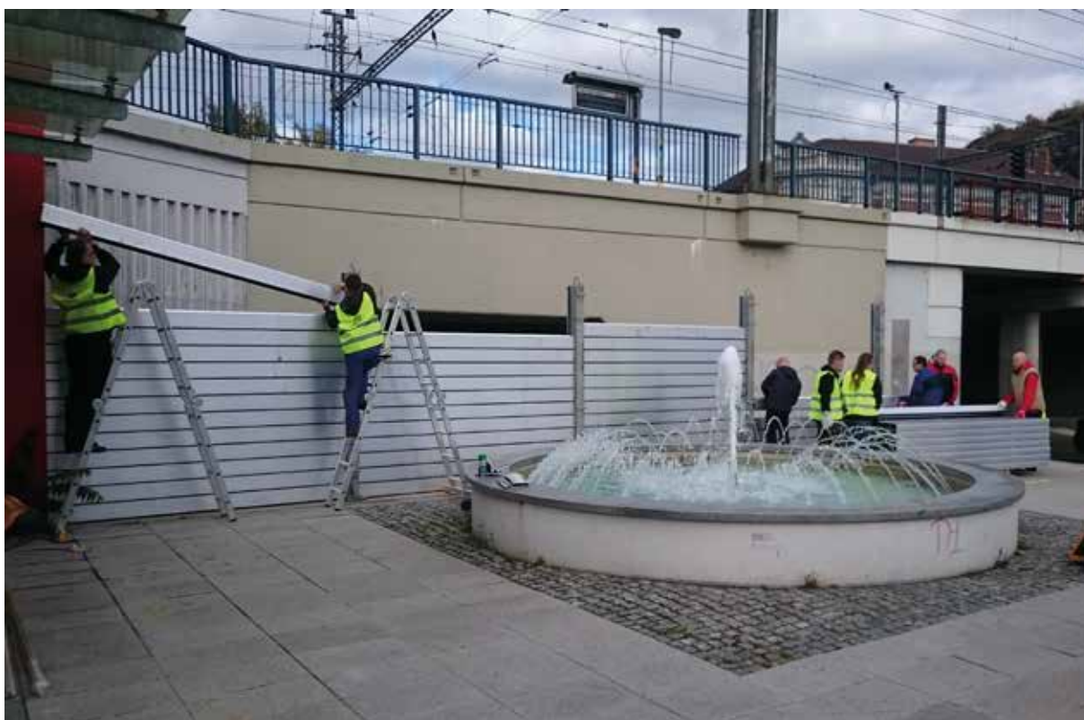
Instalace zábran u podchodu pro pěší
