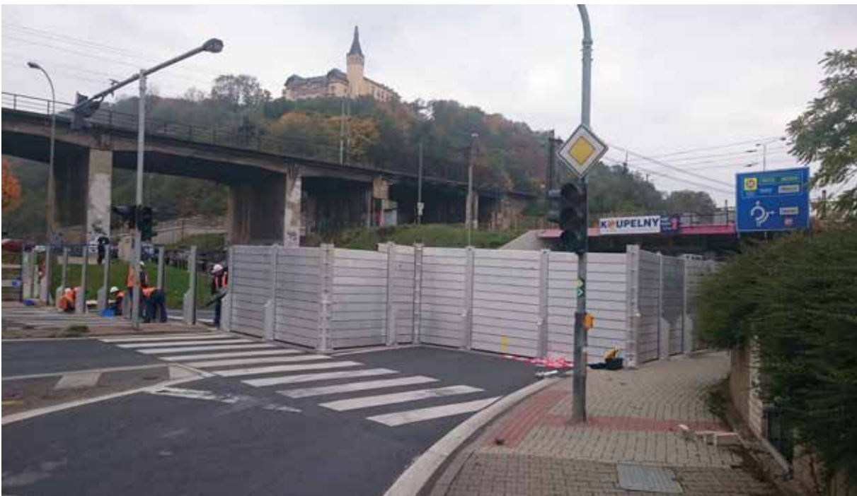
Instalace zábran v ulici Střelecká
