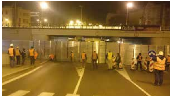
Instalace zábran za mostem Dr. E. Beneše
