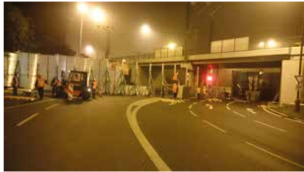
Instalace zábran v ulici Předmostí
